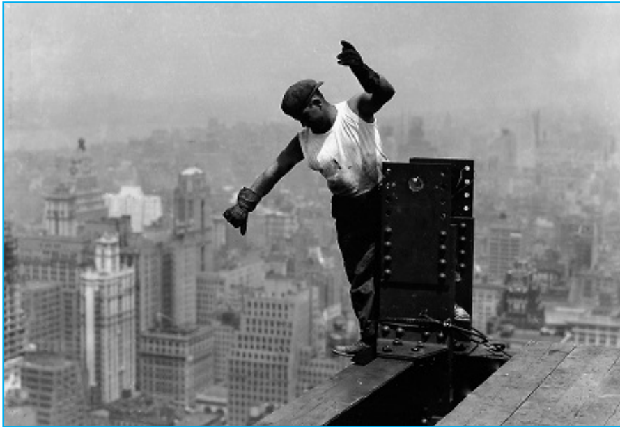
Lewis Hine, Operaio sull'Empire State Building, New York, 1931.
